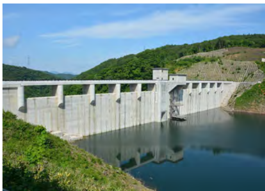
左岸上流より望む（令和3年7月）
