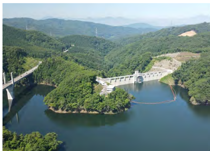
築川ダム貯水池（令和3年7月）
