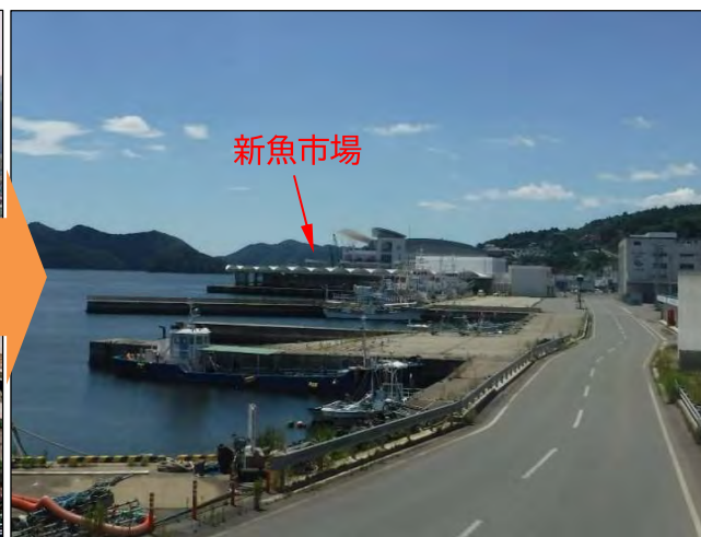
魚市場及び岸壁等関連施設
