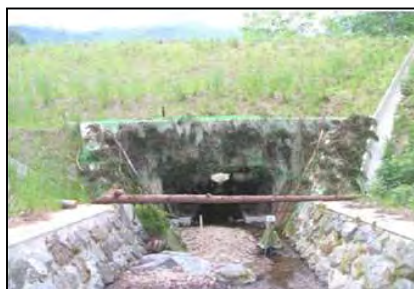
付替県道に設置したボックスカルバート (平成27年9月撮影)
