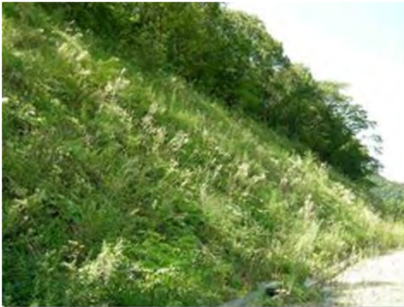
施工後5年経過した独自配合による法面の緑化状況 (平成19年9月撮影)
