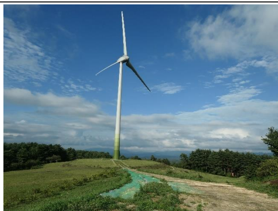
【稼働状況】6号機
