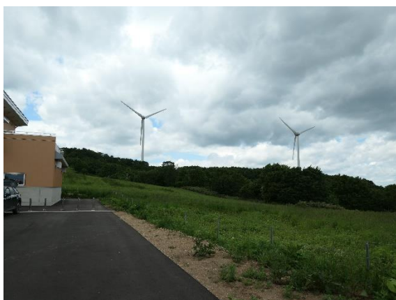
【稼働状況】1号機、2号機
