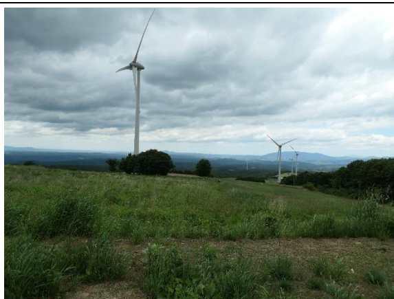
【稼働状況】2号機～7号機
