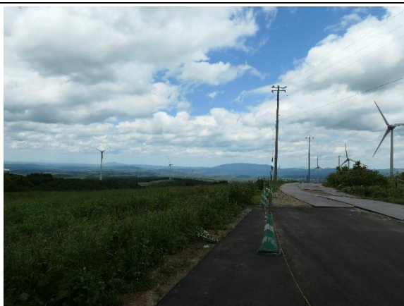
【稼働状況】4号機～11号機
