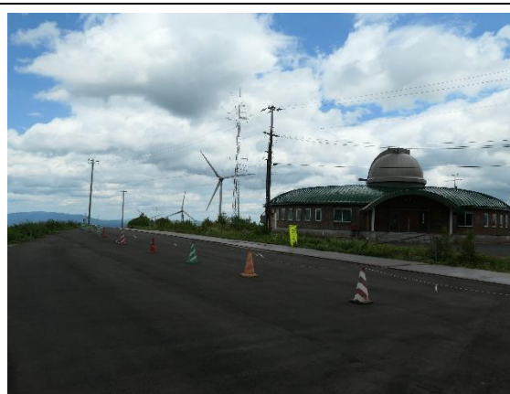
【稼働状況】8号機～9号機
