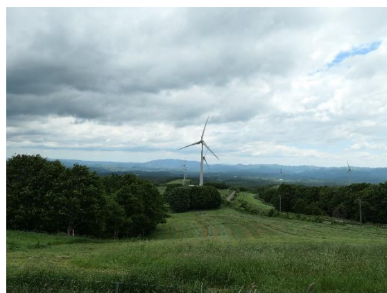
【稼働状況】3号機
