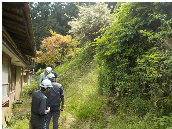
一関土木センター管内
