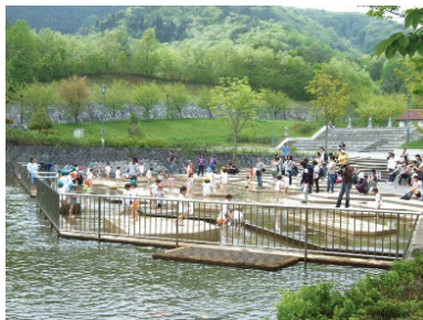
イギリス海岸（一部工事中）
