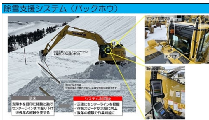
バックホウでの除雪状況
