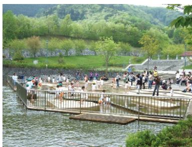
イギリス海岸（一部工事中）
