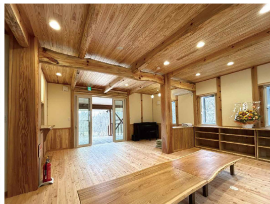
左柱は大黒柱（スギ）右柱が恵比寿柱（ケヤキ）
