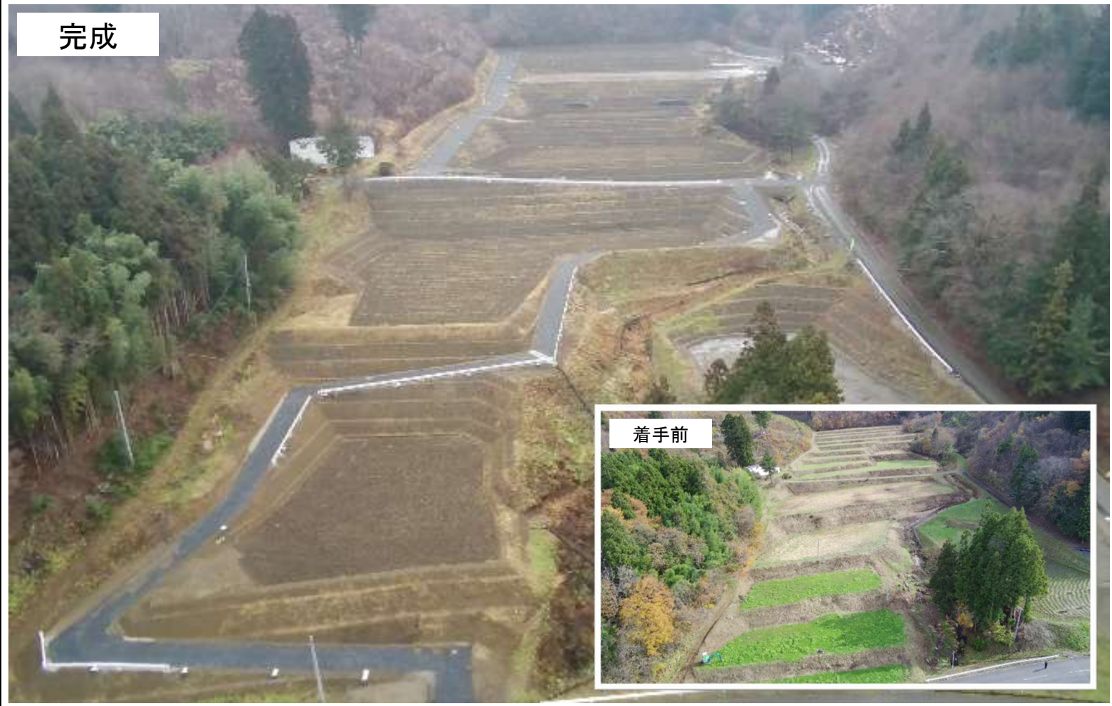
施工状況（整地工 表土戻し整地）
