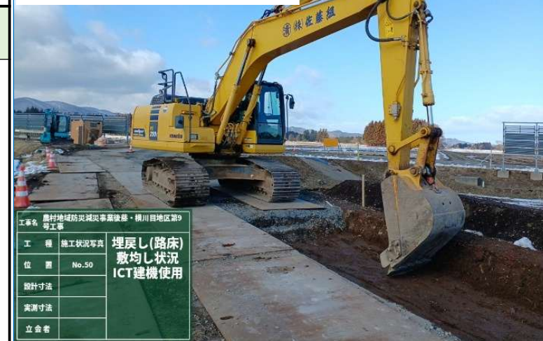
MCバックホウを用いた 路床面の整形状況
