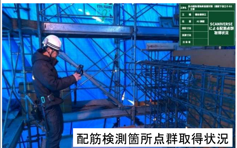
3Dモデル化による平均間隔測定
