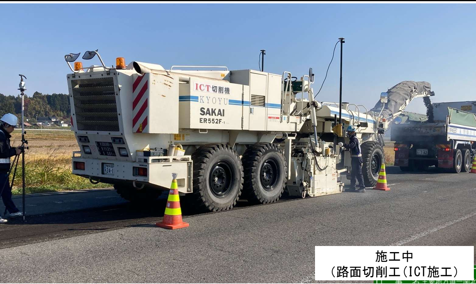
自社による3次元起工・出来形計測
