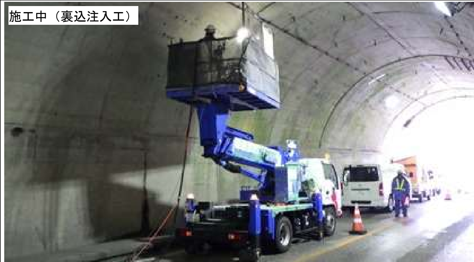
施工中（裏込注入工）
