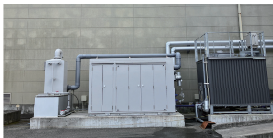
更新した冷蔵・冷凍設備
