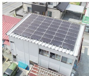
屋根上の太陽光発電設備
