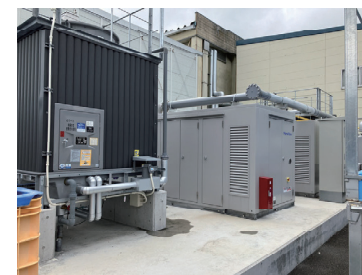
更新した冷蔵・冷凍設備
