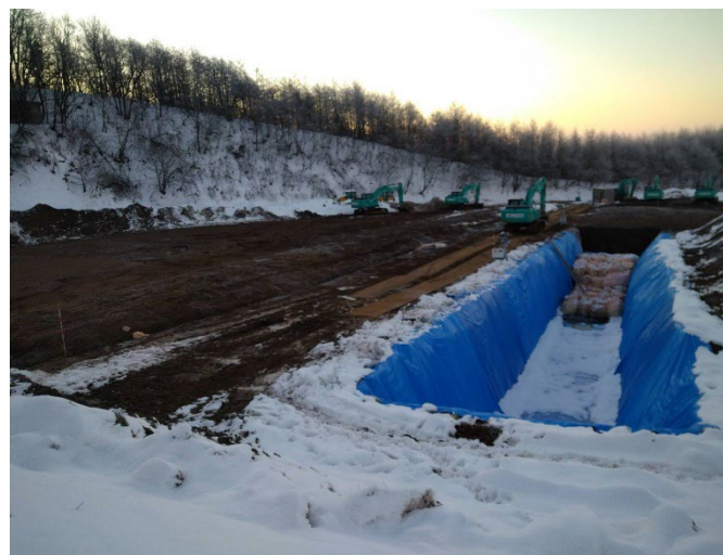
処分鶏等の埋却作業
