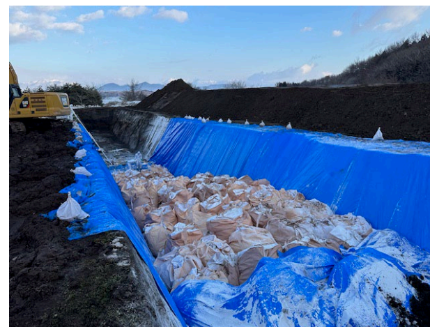
処分鶏等の埋却作業
