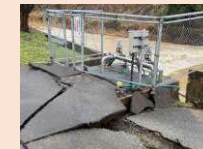
水道の復旧 (被災した浄水場)
