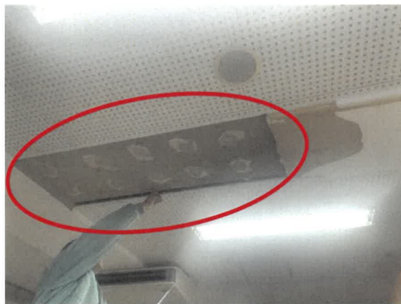
梁下に天井ボードが直張りされていた箇所
