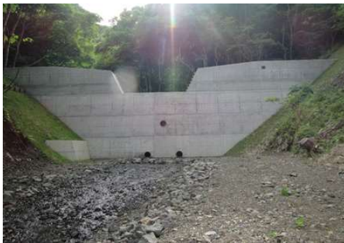
令和5年度完成 坂本沢地区 治山ダム
