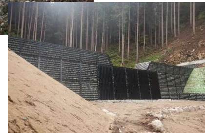
【治山工事施行後 白浜】
