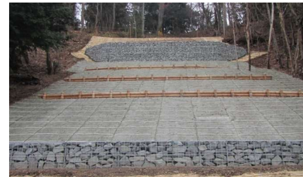
令和4年度完成 褓岩地区 山腹工
