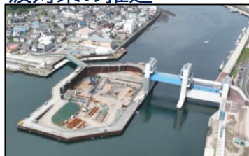
整備中の開伊川水門（宮古市）
