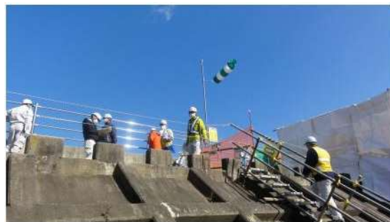
工事安全パトロールの状況
