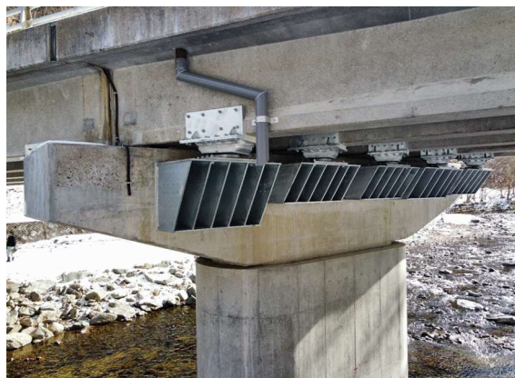
(橋梁耐震補強) 主要地方道久慈岩泉線遠川橋 【左】着工前 【右】落橋防止構造設置後 (R7 完成)
