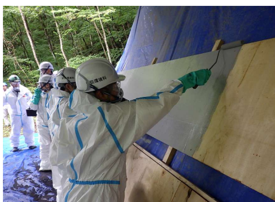
久慈工業高校橋梁メンテナンス作業体験
