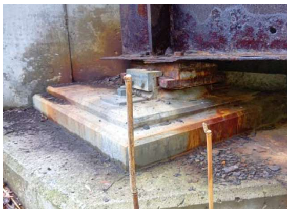
橋梁補修 主要地方道軽米種市線下大沢7の橋【左】着工前 【右】支承補修後 (R7完成)
