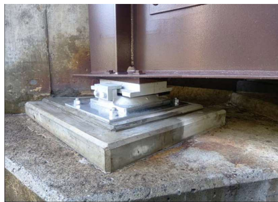
橋梁補修 主要地方道軽米種市線下大沢7の橋【左】着工前 【右】支承補修後 (R7完成)
