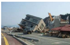
関口川 下流部右岸状況
