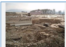
防潮堤背面の被災状況
