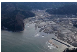
被災後の状況
