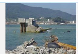
防潮堤（気仙川付近から撮影）
