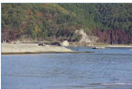
鵜住居川破壊状況
