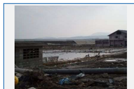
防潮堤背面の被災状況
