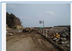
道路の被災状況
