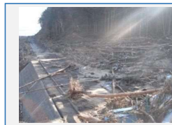
水門より下流側（右岸）の被災状況
