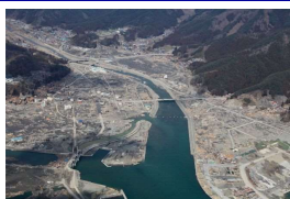
被災後の状況
