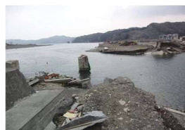
大槌川右岸 破堤地点
