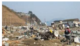
関口川 下流部左岸集落被災状況
