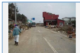
道路の被災状況
