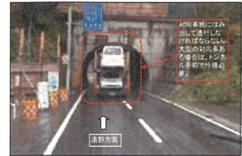
国道283号(釜石市大橋)
