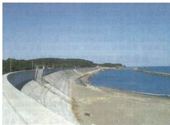
平内海岸 防潮堤整備中
