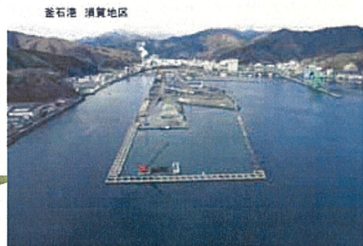
釜石港 須賀地区 平成 17 年 2 月撮影
