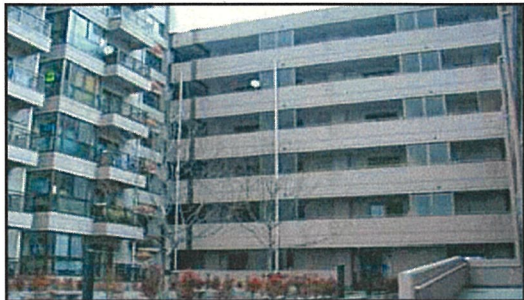
（写真：県営仙北アパート）
