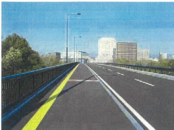
本宮側から盛岡駅西口方面
