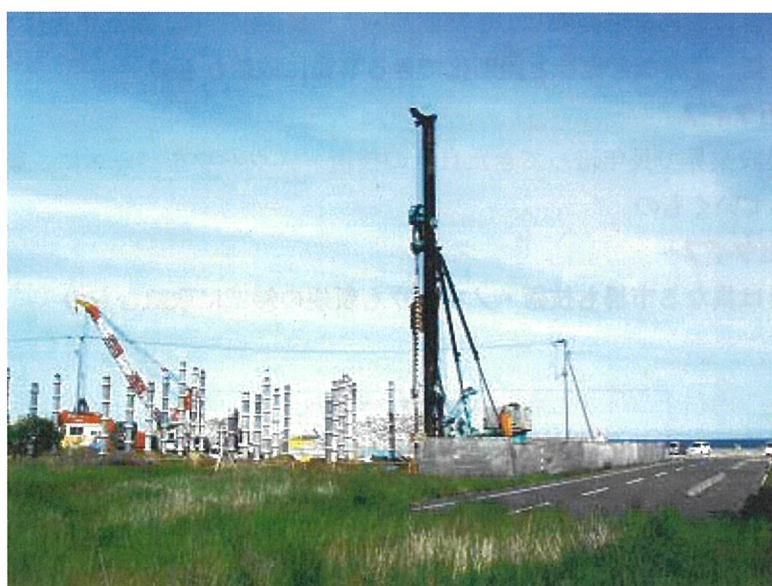
新工場建設工事風景
