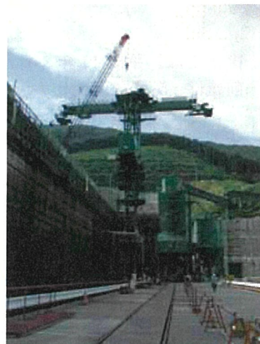
槌型クレーン（ライジングタワー）
