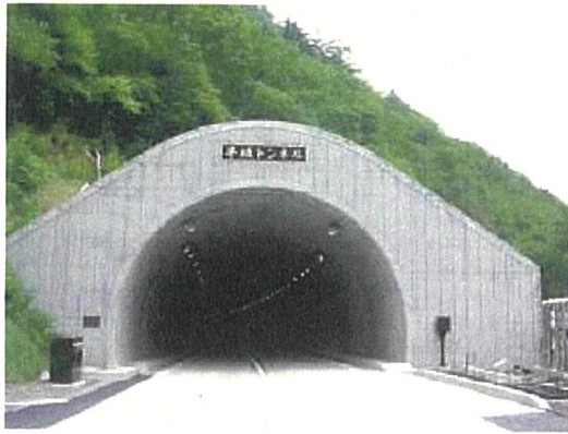
(早坂トンネル盛岡側坑口 H19.9 月撮影)
