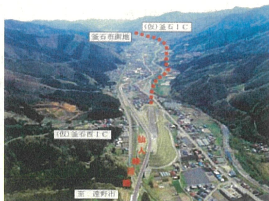
(釜石西インターから釜石側を見る)
