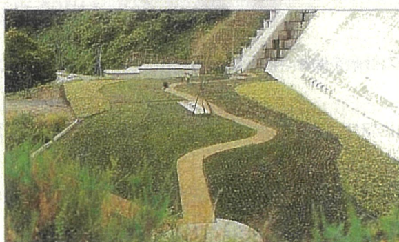
(早池峰ダム下流広場)
