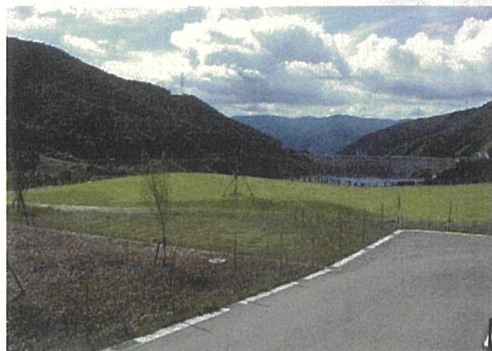
(鷹生ダム上流「ひころいち広場」)
