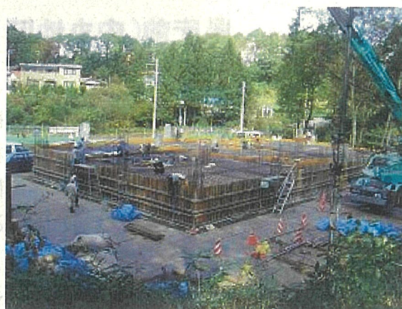
柴沢ポンプ場の施工状況
