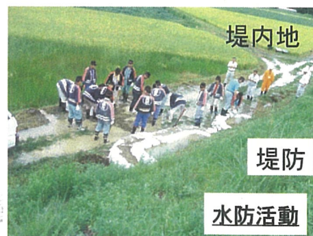
堤防法尻付近の漏水状況
