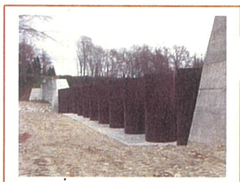
鋼製スリット部
