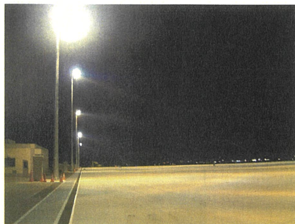
点灯状況(照度測定)
