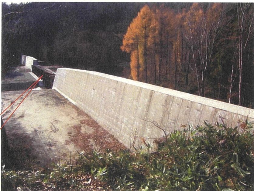
川船2号堰堤 全景
