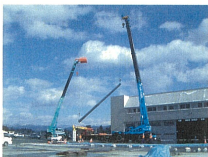
クレーン2台で柱の建て込み
