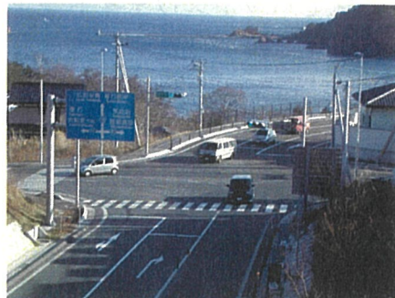
工事起点からの眺め
