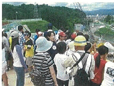
ダム建設現場
