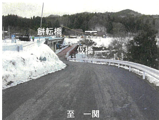
【仮設道路全景】
