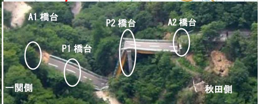
国道 342 号祭時大橋は、岩手・宮城内陸地震により落橋という、橋梁被害の中で最も深刻は被害を受けました。主な被害は、秋田側の橋台 (A2 橋台) と橋脚 (P2 橋脚) の約 11m の移動、一関側の橋台 (A1 橋台) パラペットの破断、一関側の橋脚 (P1 橋脚) の 3 分割による崩壊、主桁の破断・落下などで、過去にも類を見ない落橋の形態となりました。
