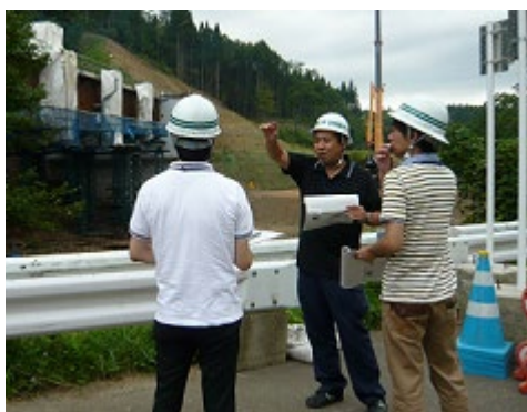
写真上：築川ダム建設現場での実習の様子
