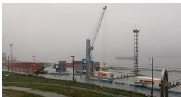
再開した大船渡港コンテナターミナル
