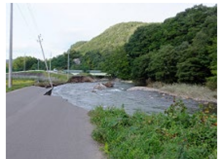
安比川軽沢橋上流左岸の護岸決壊 (八幡平市寺志田地区)
