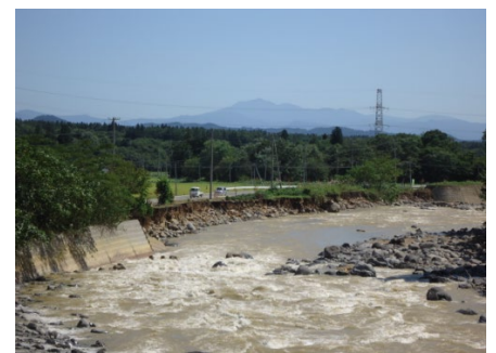
安比川軽沢橋上流左岸の護岸決壊 (八幡平市寺志田地区)
