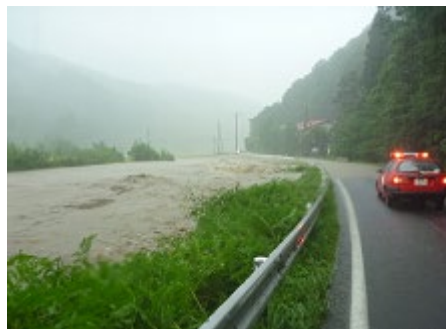
県道二戸五日市線繋沢路面冠水 (八幡平市繋沢地区)
