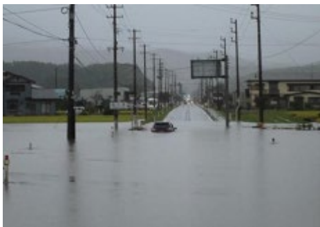
国道 282 号路面冠水(八幡平市北森地区)
