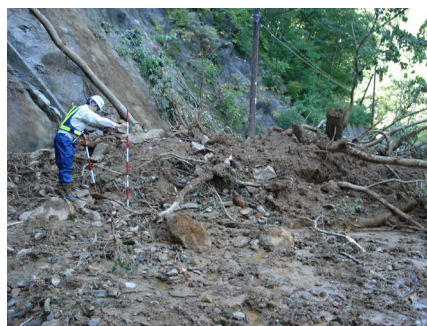
県道岩手平舘線法面崩落 (岩手町笈の峠地区)
