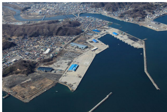
被災後（平成 23 年 3 月）
