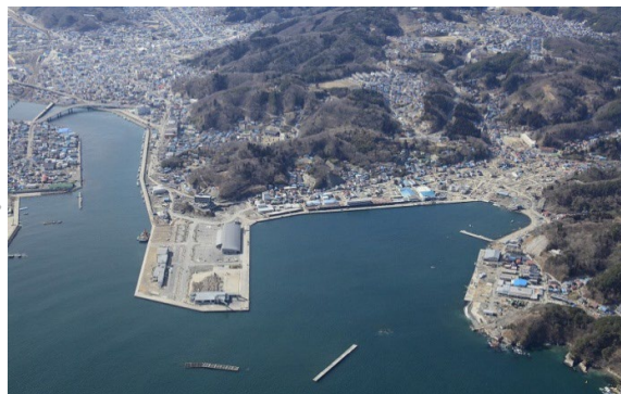
被災後(平成23年3月)
