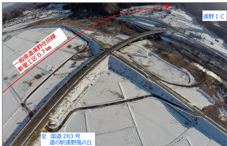
新里工区（上空から）
