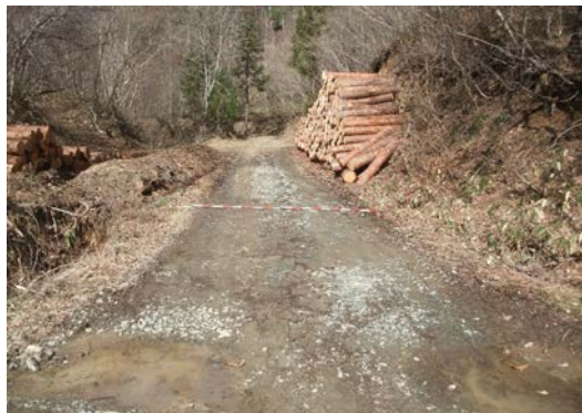
作業道 幅=4.0m
