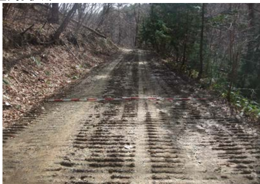
作業道 幅=4.0m
