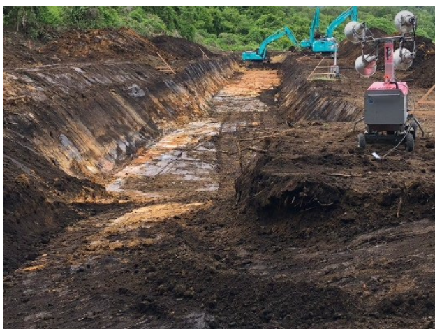
▲埋却溝の掘削：5月29日 📷①
