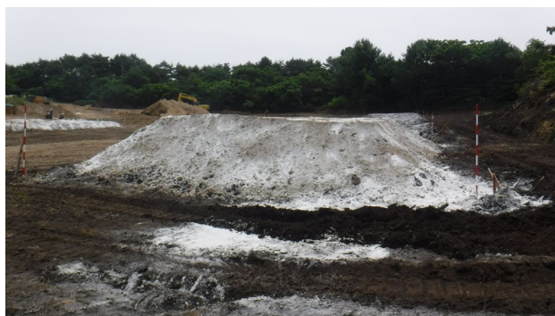
▲埋却溝の覆土：6月18日 (📷③)
