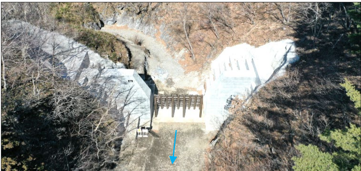
～松林の沢(新) 堰堤完成状況～
