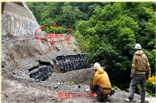
導火線 (電線) により発破スイッチと接続
