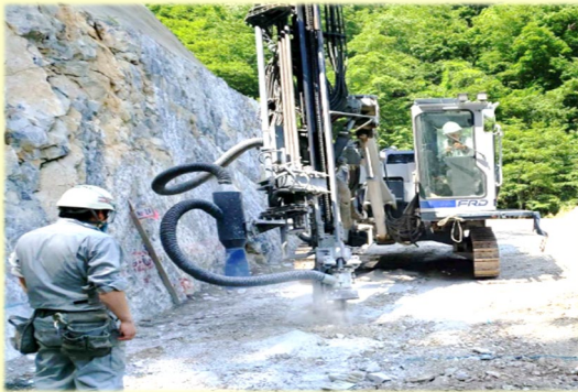
爆薬を詰める穴をあけている状況
