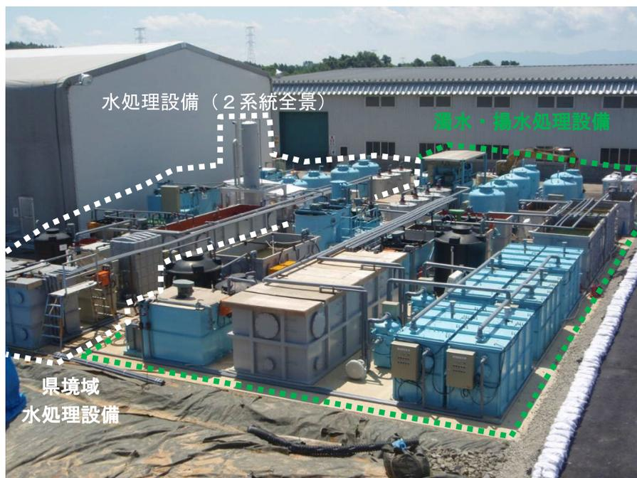
写真12 7地区浄化のための水処理施設2系統
