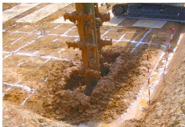
写真28 パワーブレンダーによる原位置フェントン工
