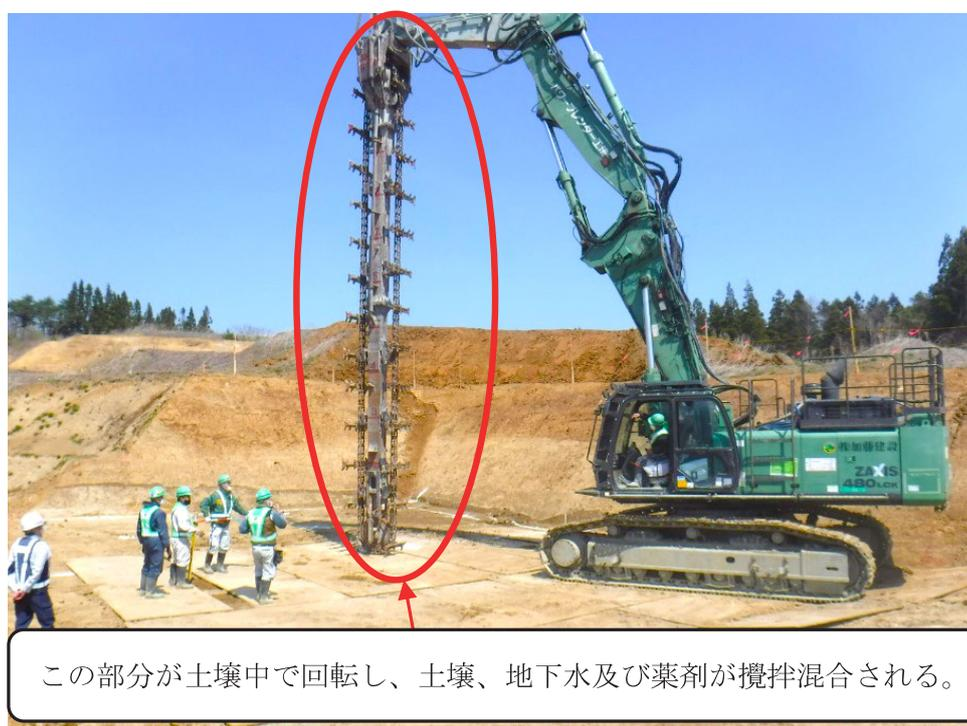
写真34 パワーブレンダー工法で使用する重機
