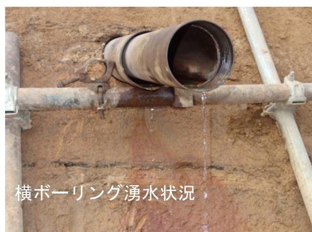
写真31 AB地区境界部北側法面横ボーリング設置状況
