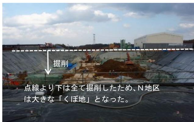
写真3 不飽和帯の掘削状況
