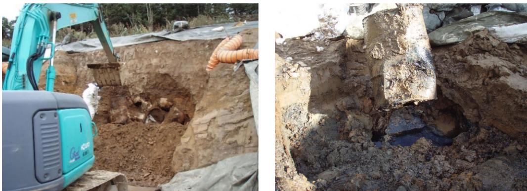
写真14 D地区でのドラム缶埋設状況
