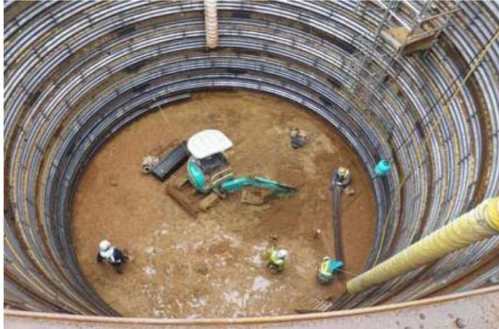
写真24 ライナープレート施工状況
