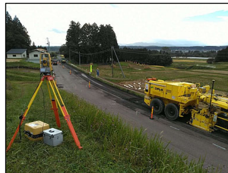
自動追尾TSによる施工精度確認
