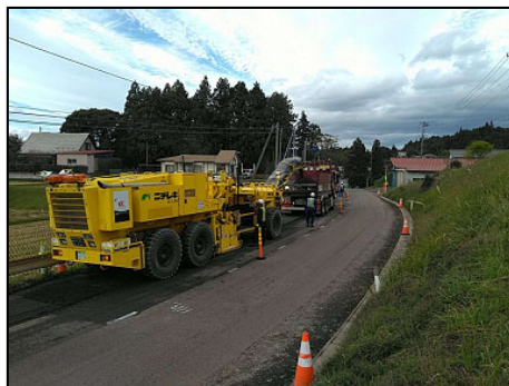
3DMCGNSS切削システムによる路面切削
