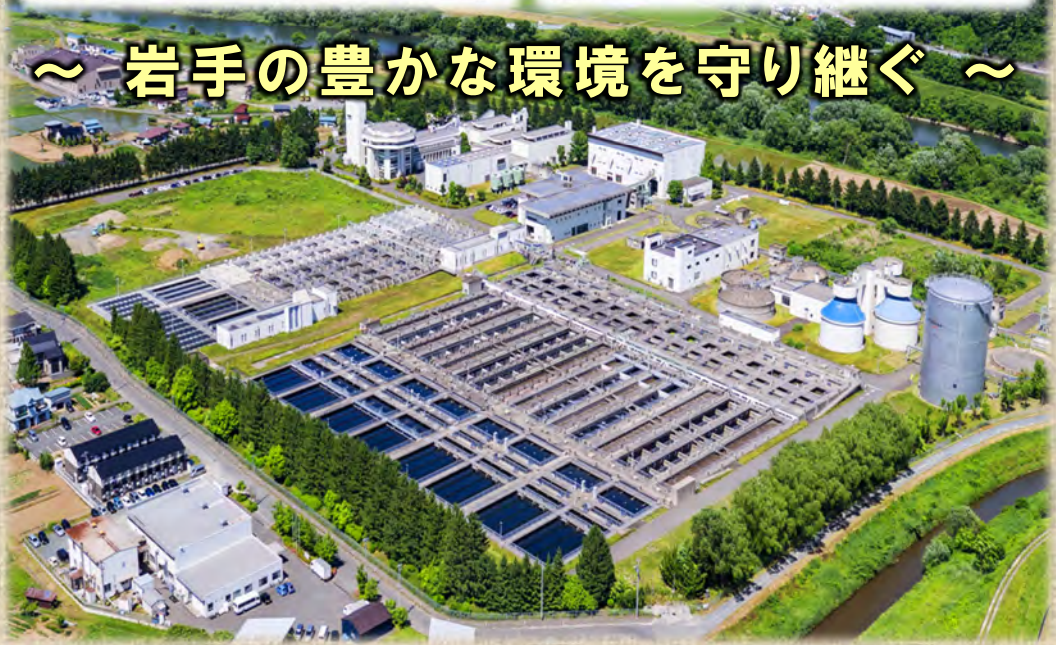
都南浄化センター（盛岡市）
