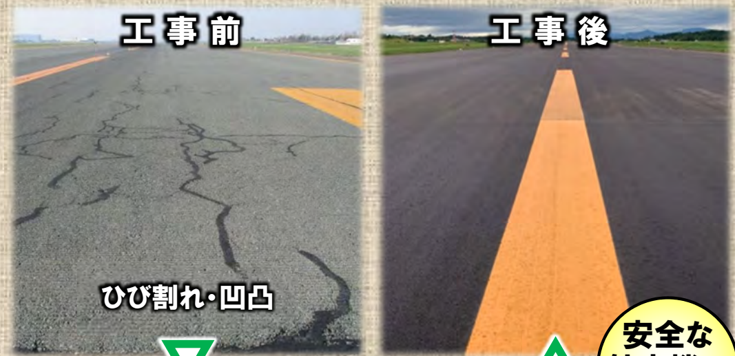
滑走路舗装改良工事 (夜間施工)
