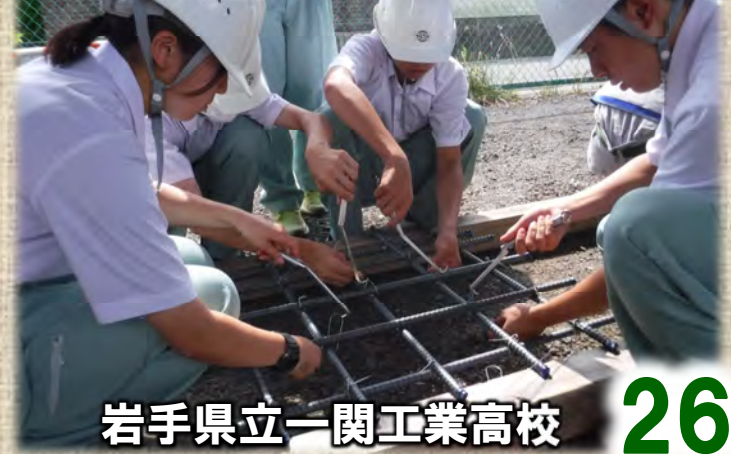
～鉄筋の組立て体験～
