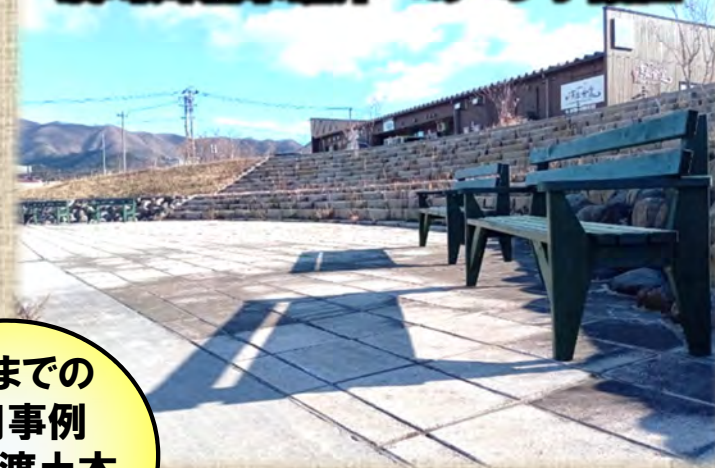
須崎川親水護岸へのベンチ設置
