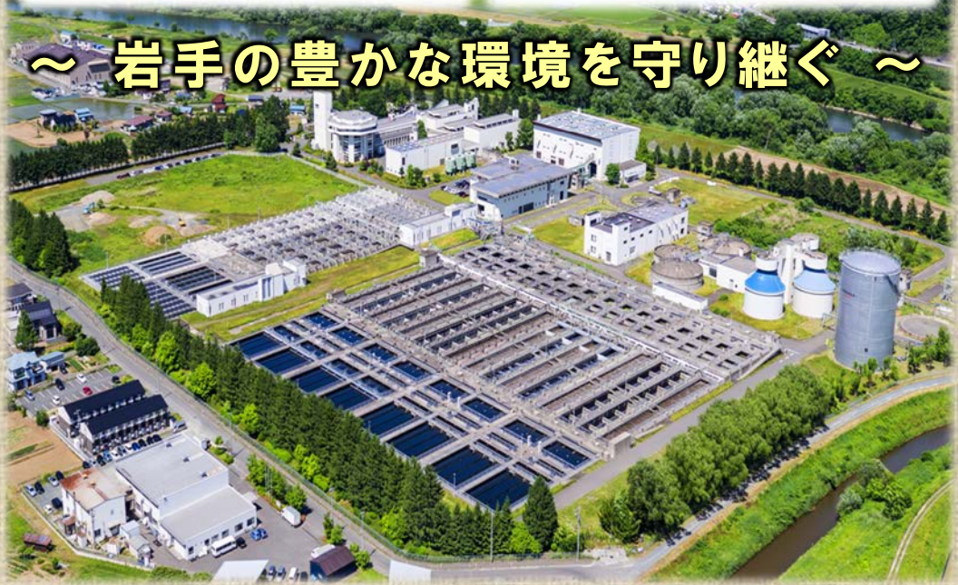
都南浄化センター（盛岡市）
