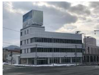
盛岡支店ビル
