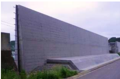
広田漁港海岸災害復旧 (23 災県第 522 号防潮堤その 2) 工事
