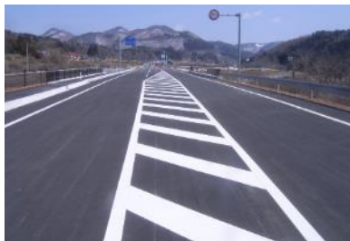
一般県道折壁大原線大原地区 道路改良舗装工事
