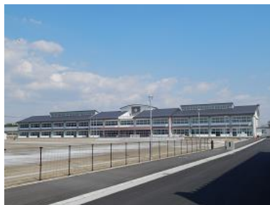
弊社で施工した 奥州市立前沢小学校
