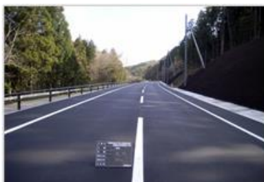
弊社で施工した国道の 道路舗装完成写真
