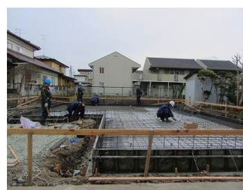
現場～基礎工事～
