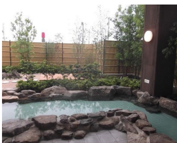
公共温泉施設 造園工事
