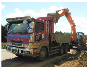
〔掘削・積込作業〕
