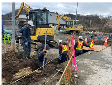
〔水路布設作業〕
