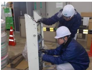
回路図をもとに盤内配線作業
