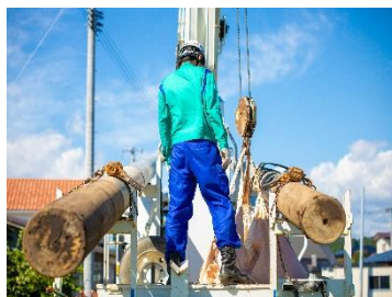
電柱設置工事
