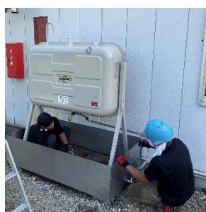
〔各種住宅設備工事〕
